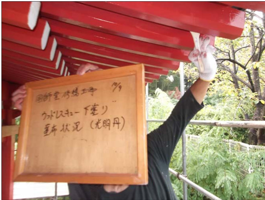
ウッドレスキュー下塗り 塗布状況（光明丹）
