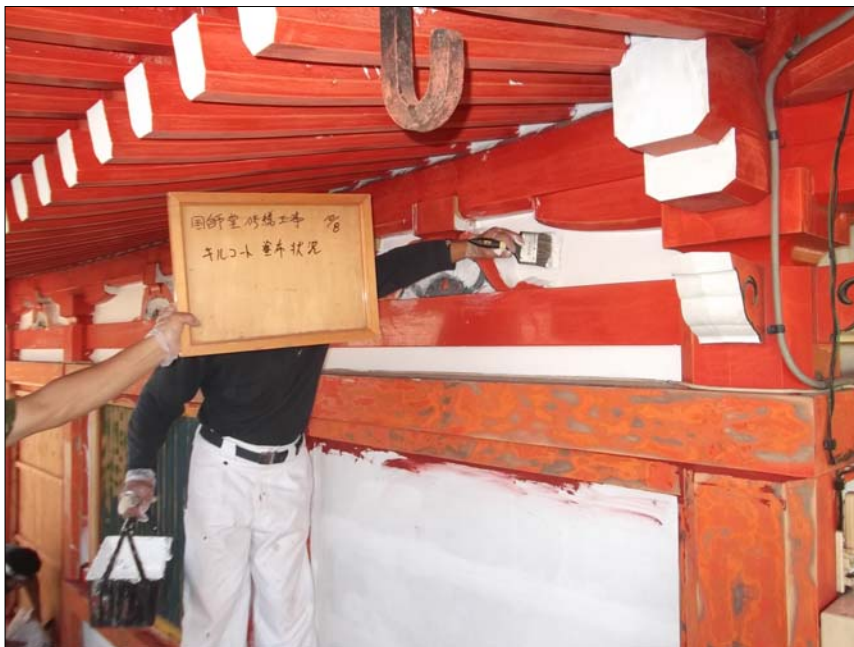
キルコート塗布状況
