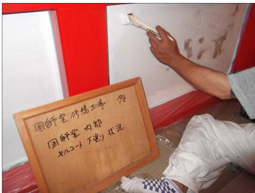
キルコート塗布状況（内部）
