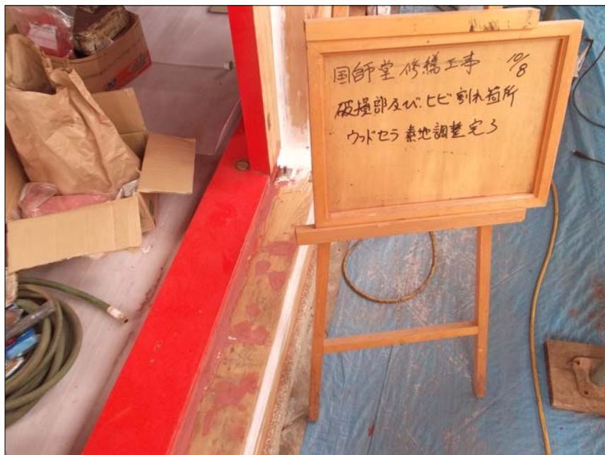
ウッドセラ素地調整完了
