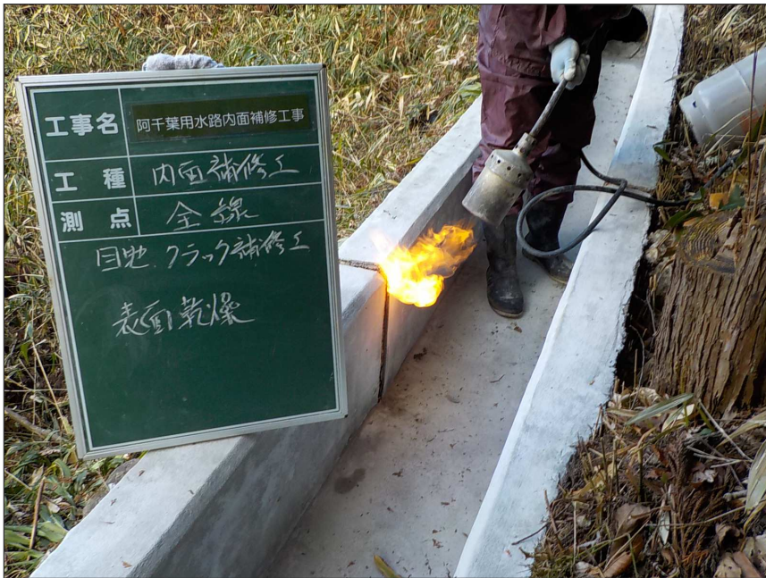
目地・クラック補修工 乾燥状況
