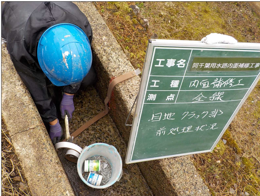
目地・クラック補修工 下処理状況
