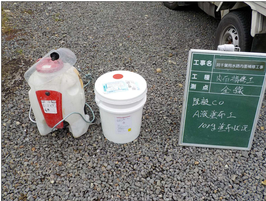
既設CO A液塗布 m 2 /100g以上塗布
